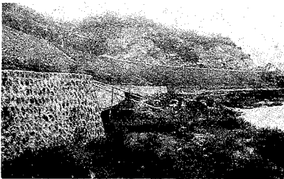
長沢駅東方2 km地点の小国川洪水に備えた築堤及護岸石垣。大正6年発行『陸羽東線建設概要』より
