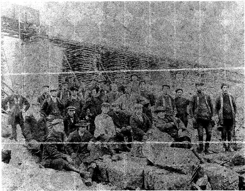
奥羽線小国川鉄橋工事（舟形）
