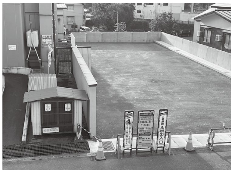
完成間近の駐車場
