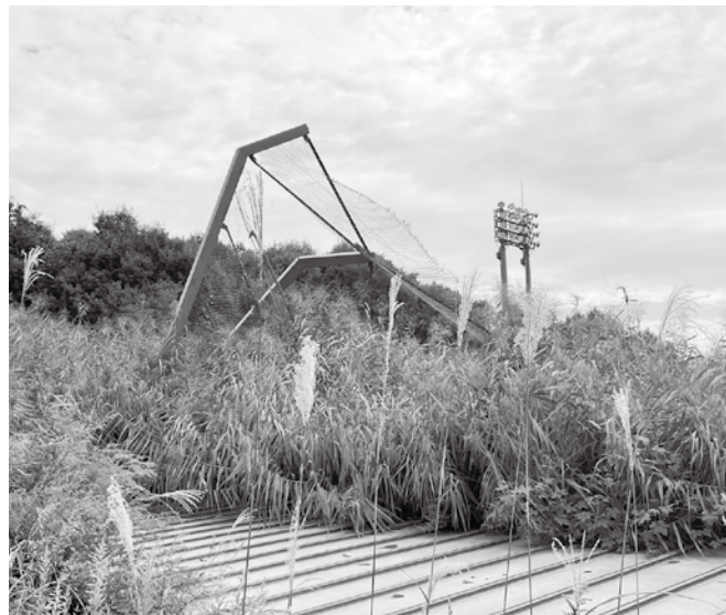
崩落によって破損したバックネット
