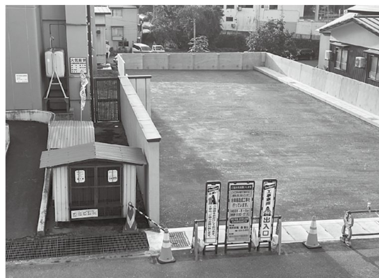
完成間近の駐車場
