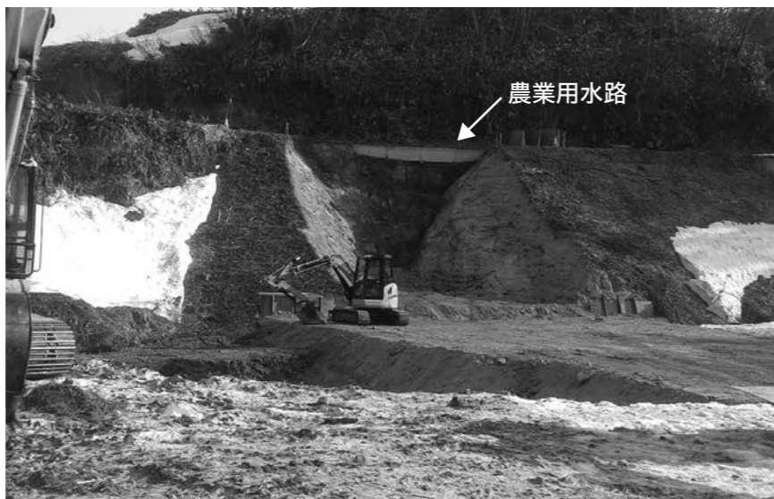
水路法面崩落箇所の復旧工事(西又地区)
