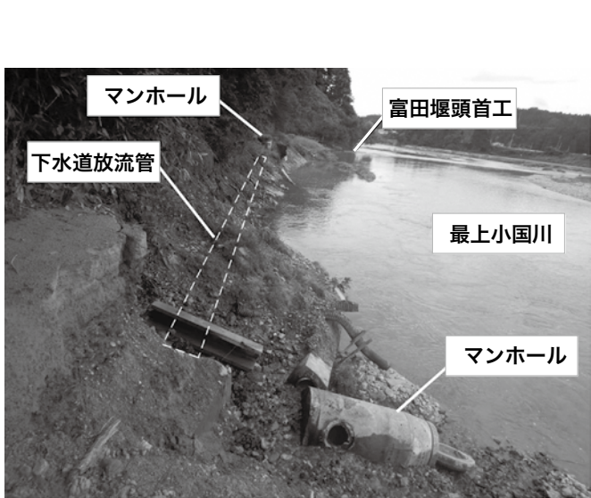
浸食、流出した下水道の放流管(小松地区対岸)
