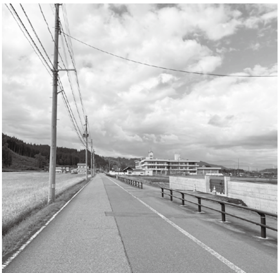
防犯灯を増設し、舗道を明るくする工事
