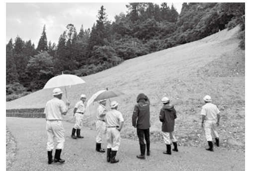
完成した「開墾堰」視察
