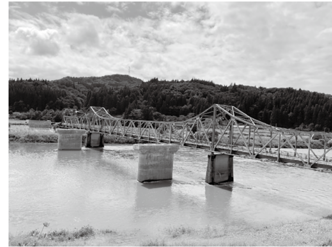
早期完成が待たれる堀内橋
