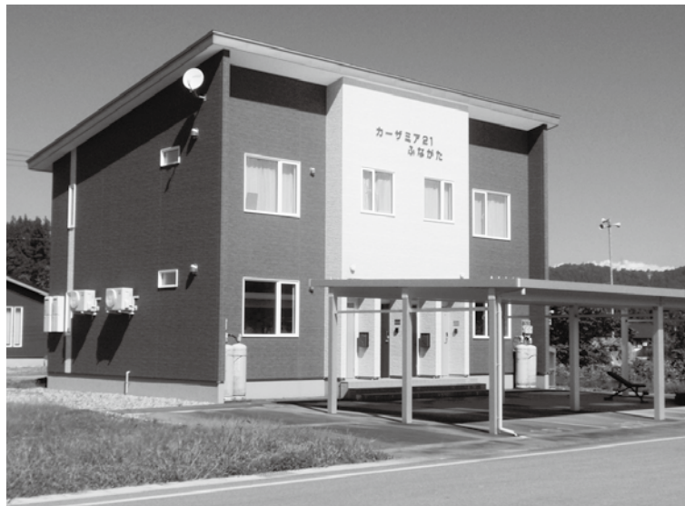
旧堀内小学校跡地の民間アパート「カーザミア21ふながた」
