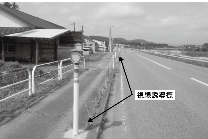
県道56号線に設置された視線誘導標
