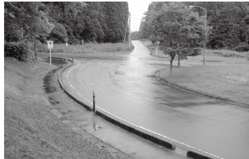
「止まれ」「停止線」が消えた状態の交差点（若あゆ温泉への出入口）
