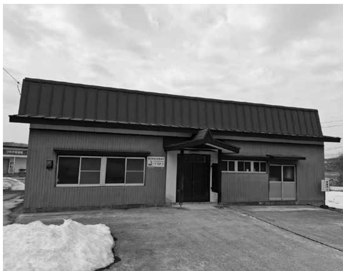
屋根の葺き替えが予定されている木友公民館
