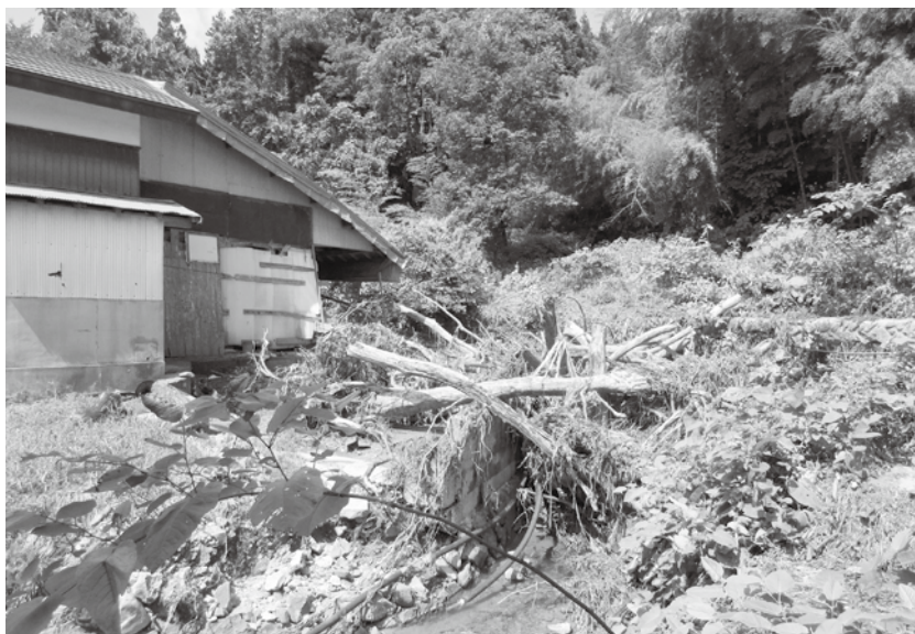
水上沢えん堤から流出した堆積していた大量の流木と土砂
