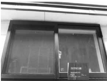
トリプルガラスを使用した 高気密・高断熱住宅
