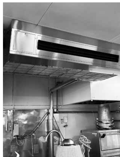
油・煙に強いステンレスタイプエアコン（2台）
