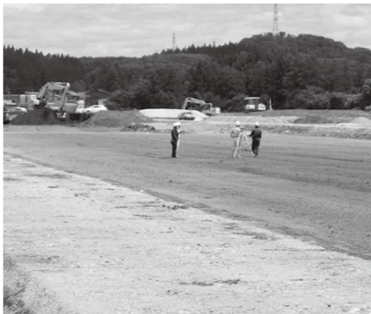
基盤整備現場
