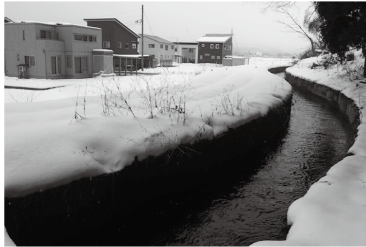
老朽化により改修予定の大堰
