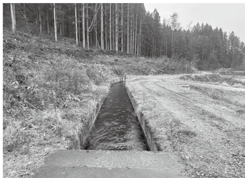
早期改修工事が望まれる大堰
