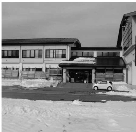
工事が完成した農村環境改善センター
