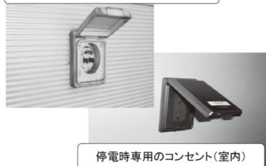
発電機からの受電用コンセント(外壁)
