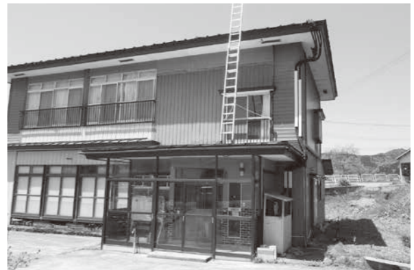
解体予定の空き家
