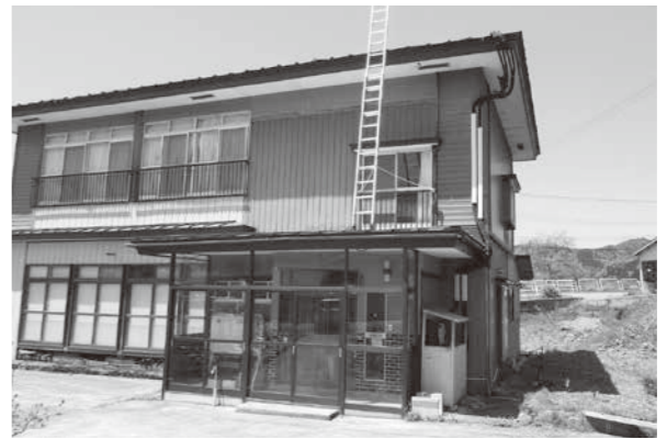
解体予定の空き家
