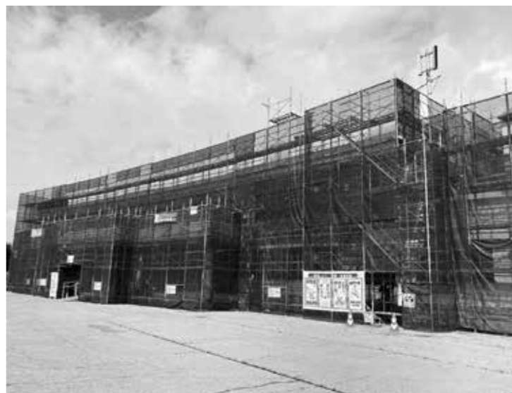
改修中の生涯学習センターのようす
