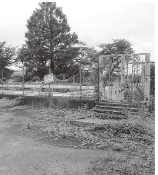
荒廃が進むプール
