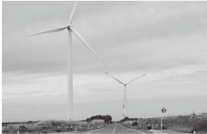
風力発電、舟形町にも導入できないか
