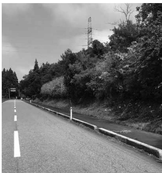
荒廃が進むこぶしの道
