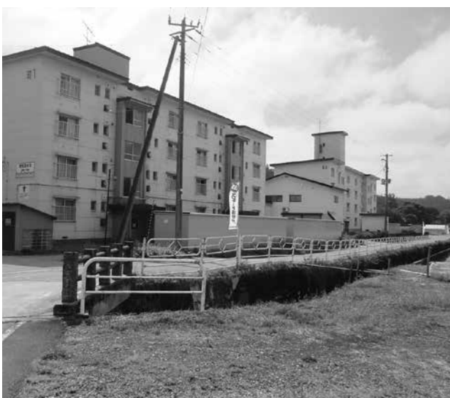
老朽度調査を実施している町営住宅
