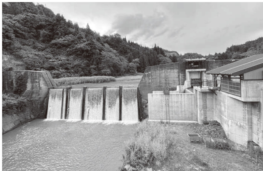
升玉水力発電所、村では電気代を無料にできないかとがんばる
