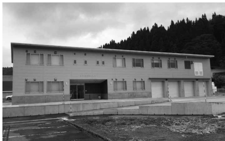
町民の安全安心が高まった防災センター
