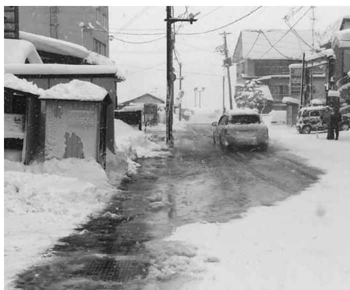
問題の多かった流雪溝の改修が進んでいる
