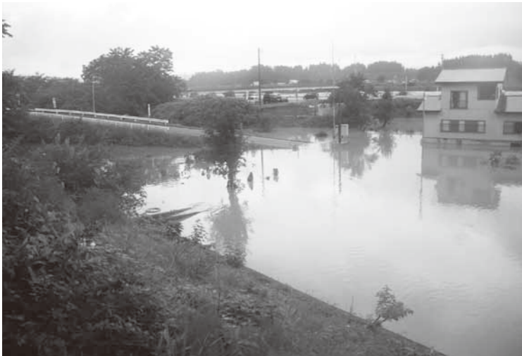
最上小国川の逆流により浸水した寺下地区
