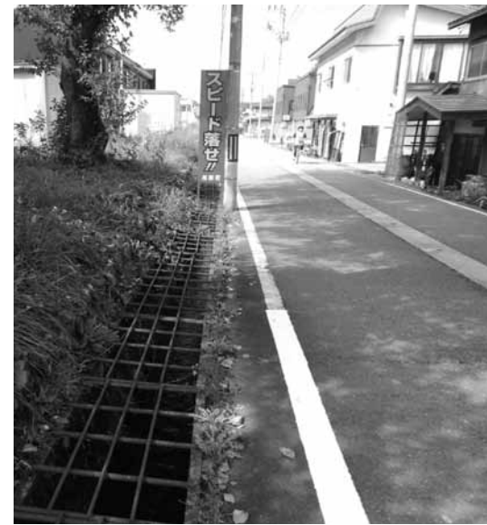
鉄筋網の蓋がかけられた通学路
