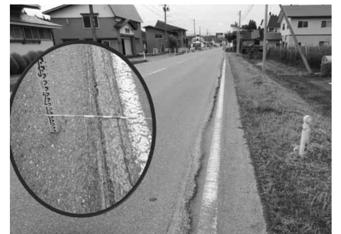
10cmの段差が生じている県道56号線(一の関地内)
