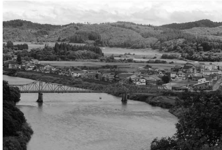
竣工から65年経過した堀内橋
