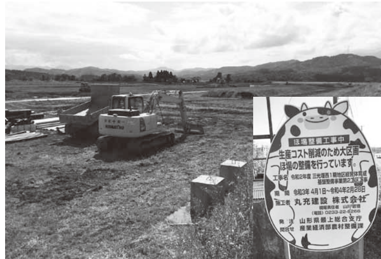
生産コスト削減のため大区画ほ場の整備を実施
