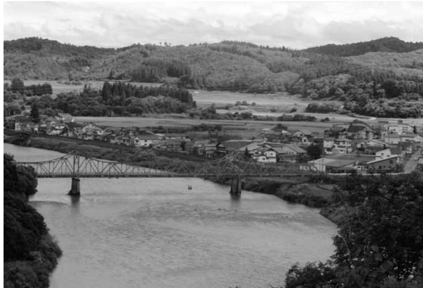
竣工から65年経過した堀内橋
