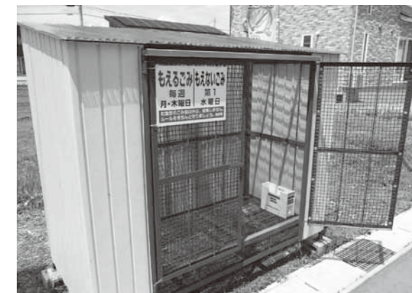
早速設置された乾電池回収用ボックス
