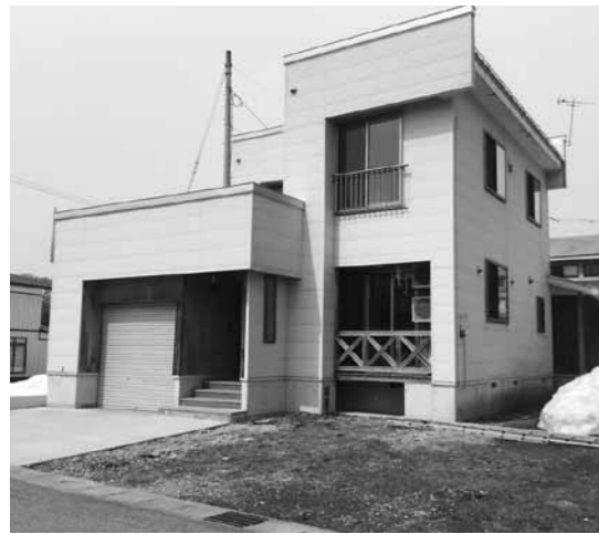
改修が終了した新雪国エコ環境住宅(洲崎地内)
