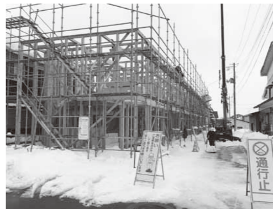
現在建設中の2棟目の民間賃貸共同住宅
