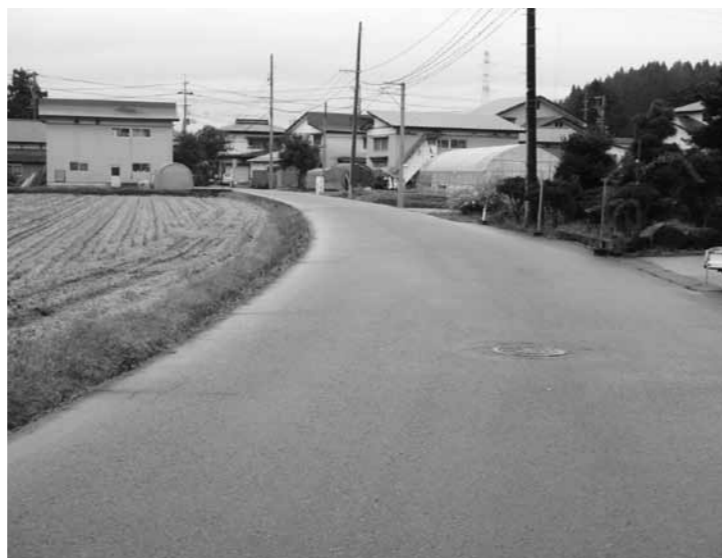
早期の改修が望まれる福寿野岡矢場線
