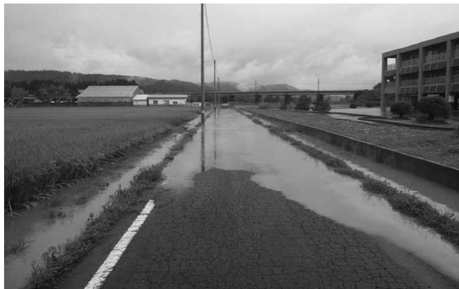
平成30年8月の豪雨で洪水による浸水被害にあった光生園と稚鮎センター
