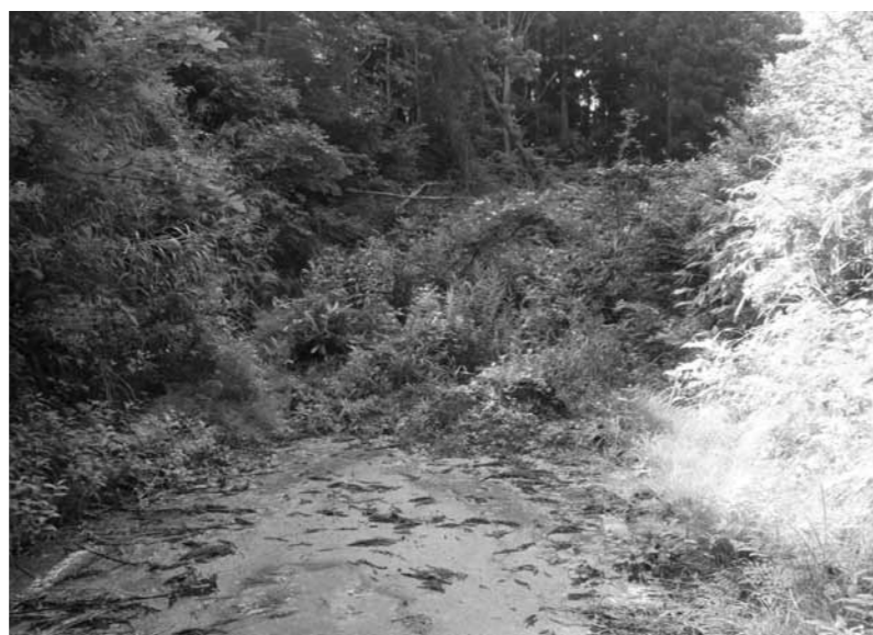
災害により通行不可能な林道（富田猿羽根山線）
