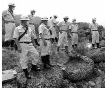
開墾堰頭首工取水施設の被害状況を確認 (松橋)
