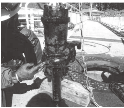
マンホールポンプの点検状況
