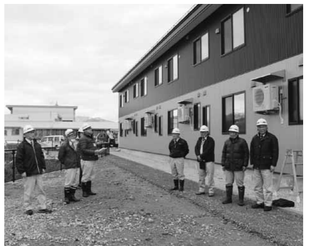
完成間近な「エスポワールI」を視察説明を受ける
