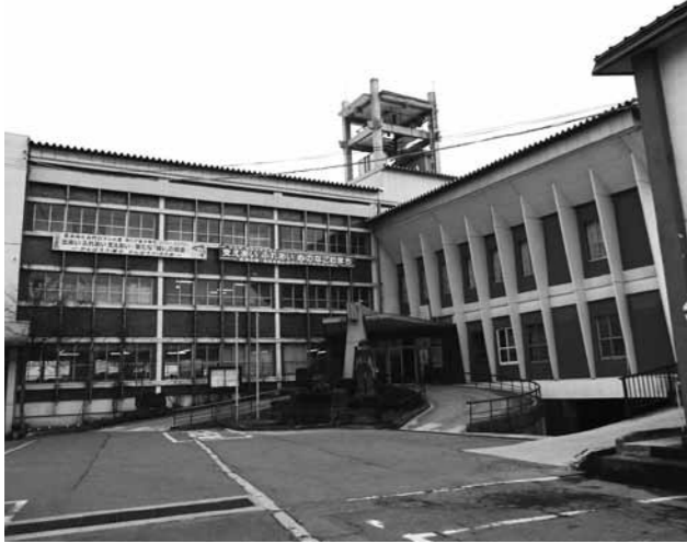
耐震補強工事を行う役場庁舎
