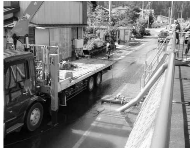
町道堀内川端線の大型ポンプによる排水作業
