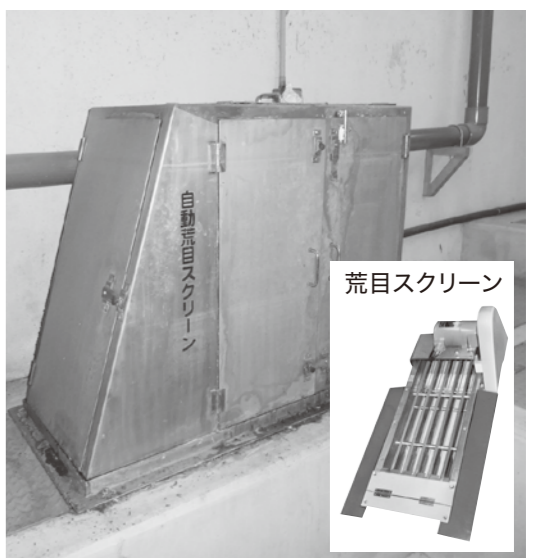
修繕される長沢処理場の自動荒目スクリーン
