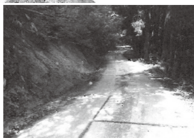
復旧工事が完了した町道舟形平沢長沢線
