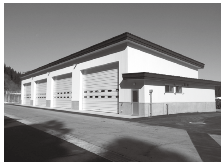
公共下水道処理施設前に完成した除雪機格納庫
