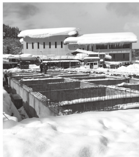
工期内の完成を目指し進められている建築工事
