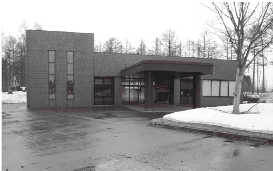
平成2年に建てられたうと山斎場
