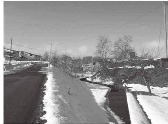
小国川からの水の逆流を防ぐ対策が必要とされる寺下地区
