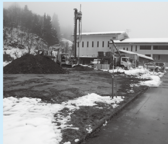
工事に着手した除雪センター建築工事現場
