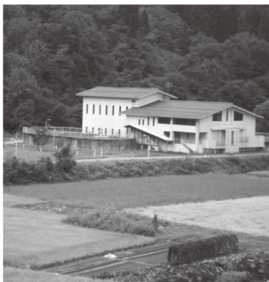
変更になった除雪機械格納庫建設予定地
