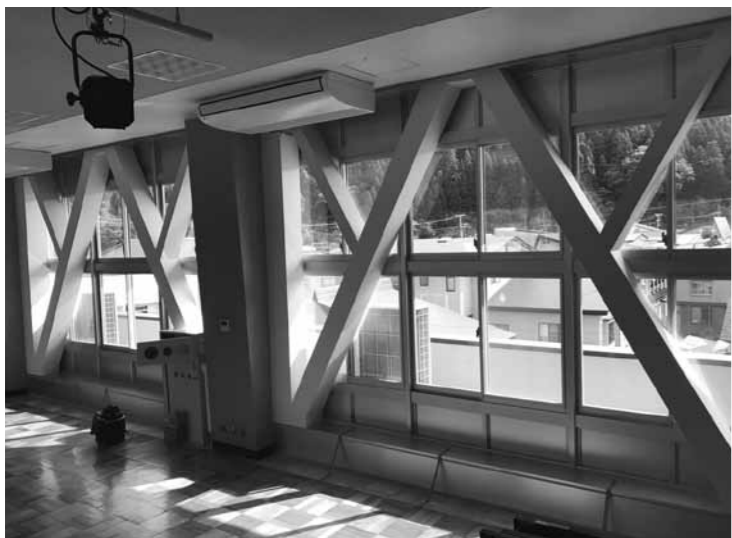
耐震工事が完了し安心して使えるようになった中央公民館
