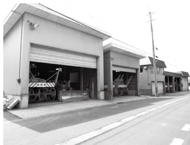
移転される除雪機格納庫
