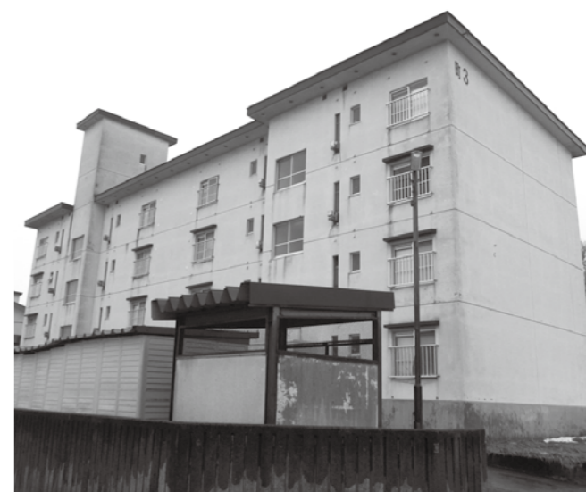
改修工事予定の町営住宅3号棟
