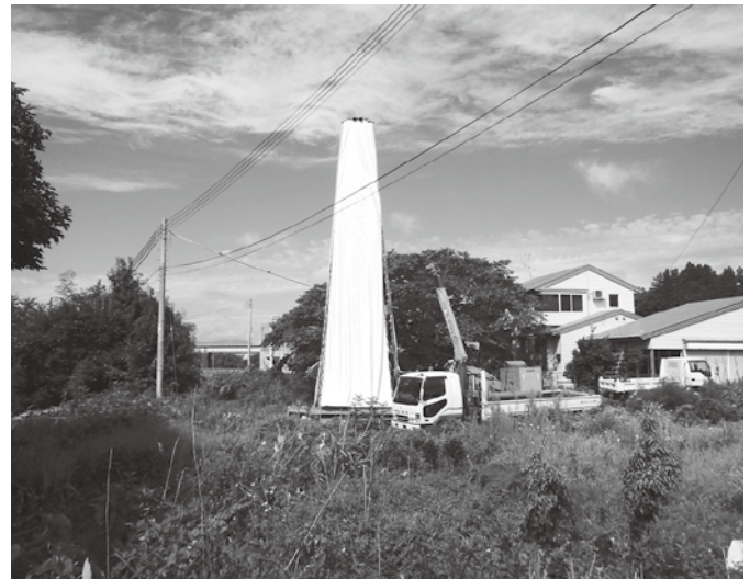
サケふ化場水源井戸掘削
