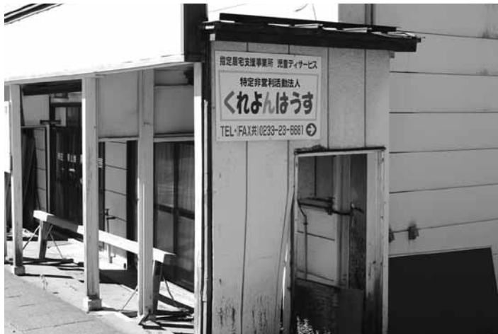
障がい者が活用している施設
