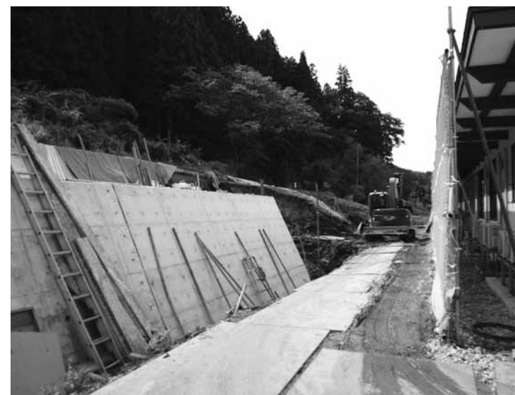
ほなみ裏の急傾斜地工事
