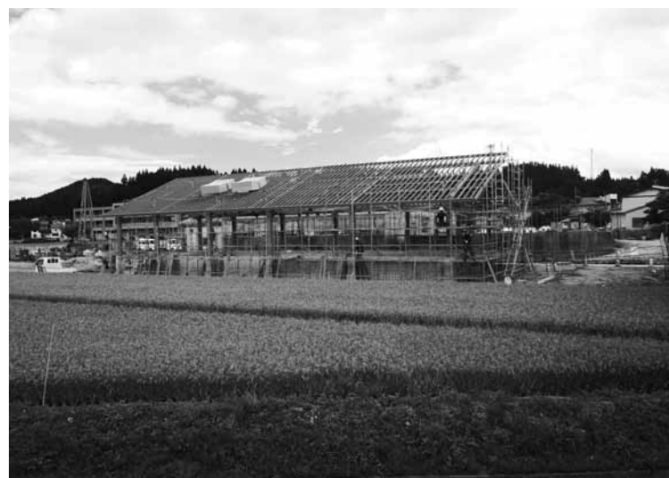
アユの中間育成施設に隣接するサケふ化場新築工事
