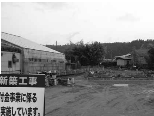
サケふ化場の新築工事
