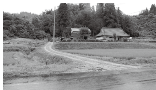
整備予定の生活道路
