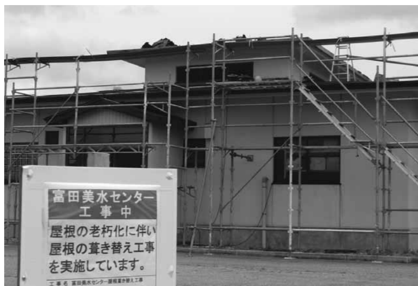
修繕が進む富田美水センター
