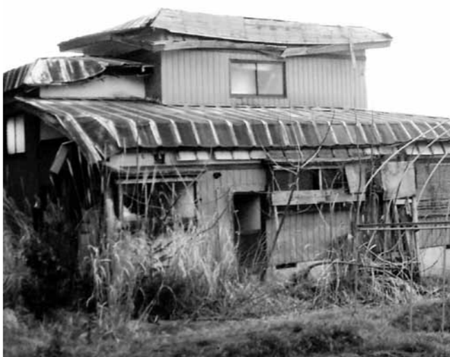
対応が待たれる危険な空き家
