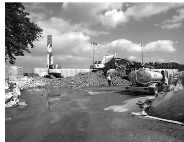
最終段階にある解体作業
