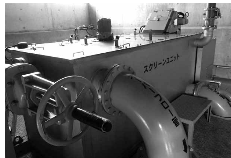
修繕中のスクリーンユニット
