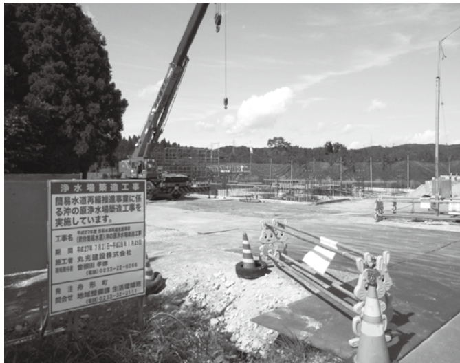
沖の原浄水場建設工事現場
