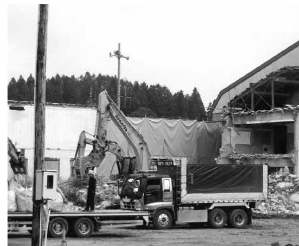
解体が進む堀内交流センター
