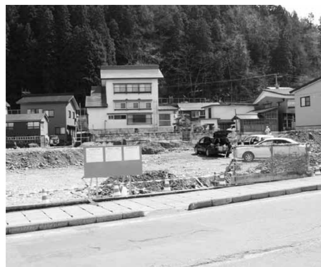
工事が始まったコンビニ予定地
