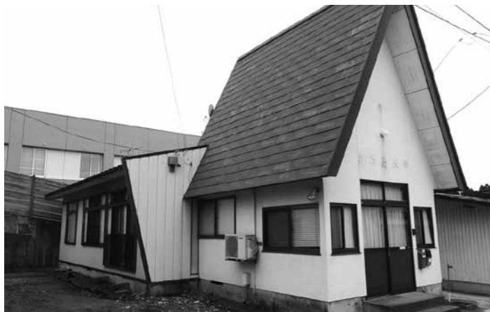
定住促進住宅になった旧舟形駐在所
