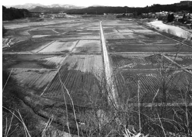
27年基盤整備着工（小松地区）
