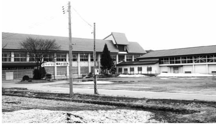
特別養護老人ホーム建設予定地（旧堀内小）
