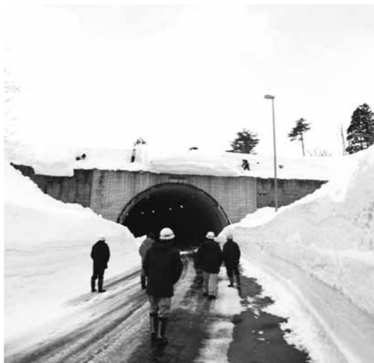
除雪の状況を視察(若あゆ温泉トンネル)
