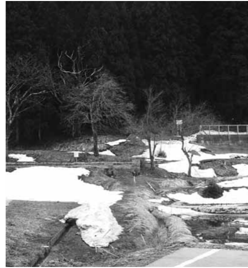
ほなみ裏の急傾斜地
