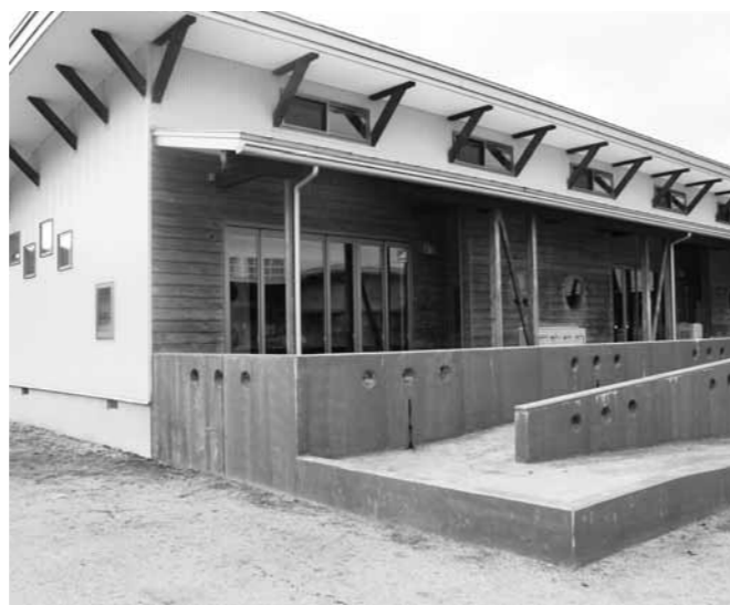
改修予定の保育園避難通路
