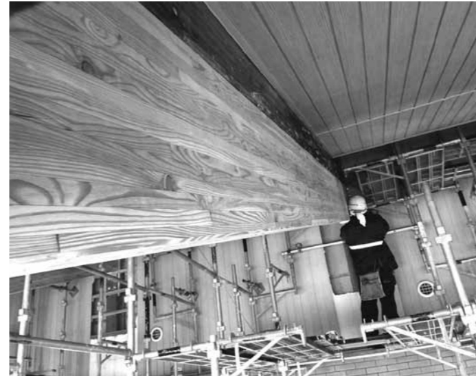
はり 梁の架け替え工事（若あゆ温泉）
