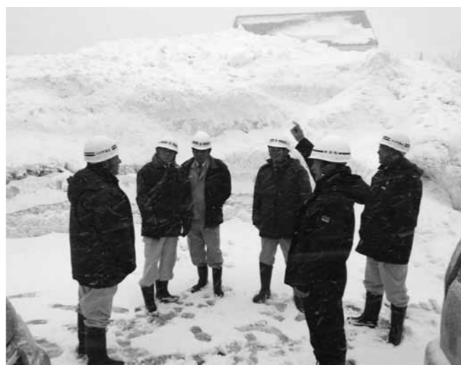
除雪状況 (富田地内)
