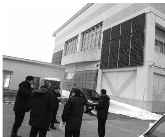
舟形小学校に設置された太陽光パネル
